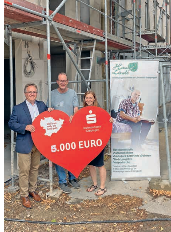
Spatenstich in Rosswälden: Hier entstehen barrierefreie Wohnungen und Pflegezimmer
